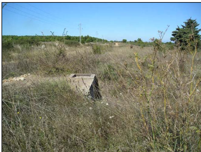
- postojeća infrastruktura: cjevovodi i elektroopskrbni dalekovod
