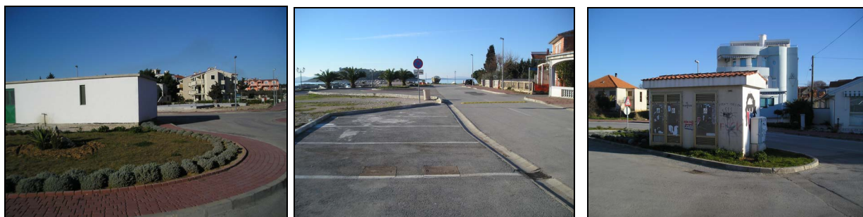
- infrastrukturni objekti (crpna stanica, parkirališta, trafostanica)
